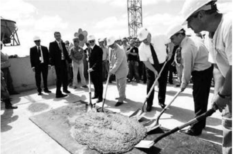
Будівництво Посольства США в Україні Construction of the Embassy of the USA in Ukraine
